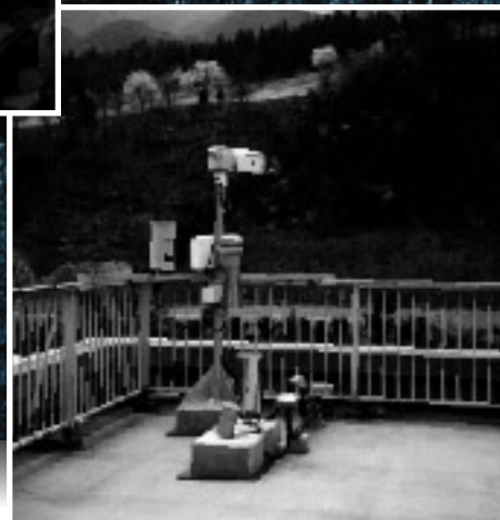
庁舎屋上の気象観測機器群
