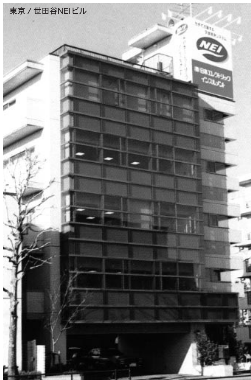
東京 / 世田谷NEIビル
